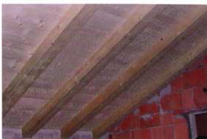
Visto dall'interno del locale il Solaioforma ® sembrerebbe un qualsiasi solaio perlinato. Pur con notevoli sovraccarichi e rilevanti luci, la sezione in vista del travetto è modesta
