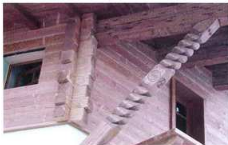
L'Hotel Helvetia di Livigno in fase di avanzata ristrutturazione. Anche i balconi sono sostenuti con sistemi a barre metalliche ed applicazione dell'adesivo Xepox ®
