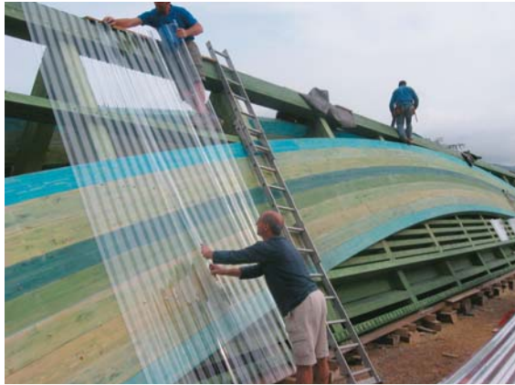
Protezione esterna in policarbonato trasparente (Lexan) e, la stessa notte, sollevamento e varo della passerella.
