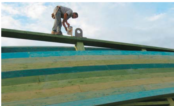
Fasi di completamento degli archi Legnoforma® e fissaggio dei ganci di sollevamento.
