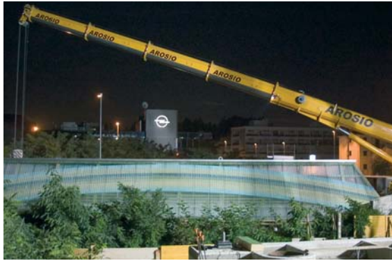
Protezione esterna in policarbonato trasparente (Lexan) e, la stessa notte, sollevamento e varo della passerella.
