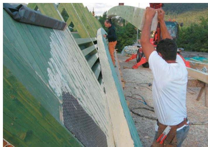
Nella pagina precedente l'impermeabilizzazione interna con tessuto di vetro E ed adesivo Xepox 14 (sistema Polyevery®). In questa pagina la ricomposizione degli archi con la tecnica di riassetto cantieristico Traveforma®.
