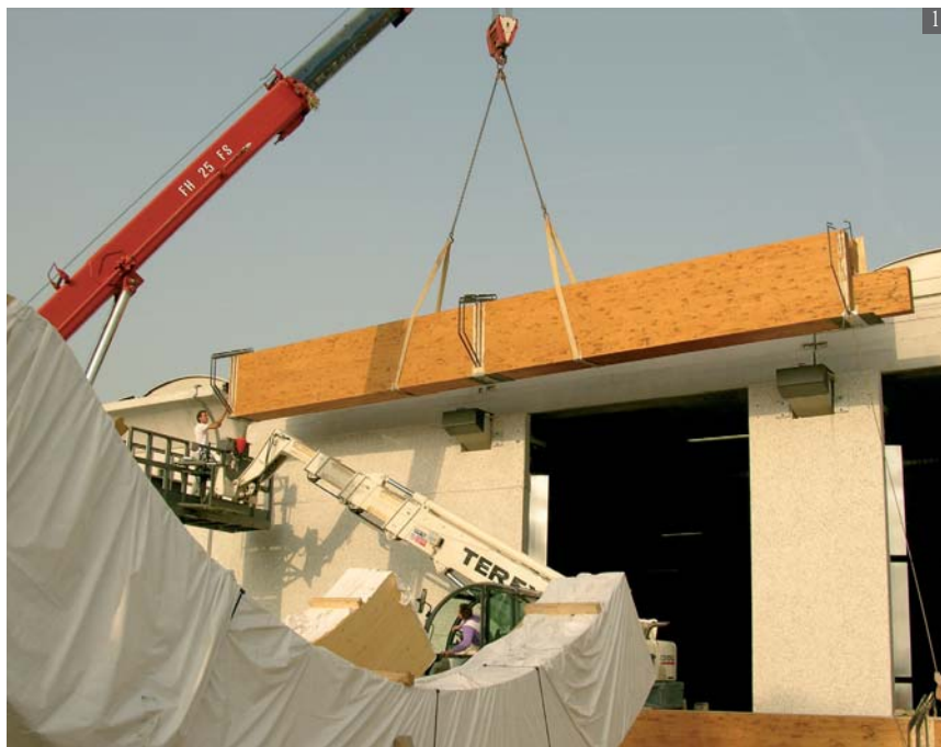
Foto 1 e 7 - Fase di montaggio e vista in opera di un tronco di trave-cassetta su appoggi scorrevoli, già dotata dei sistemi di incastro per ricevere le travi arco.
