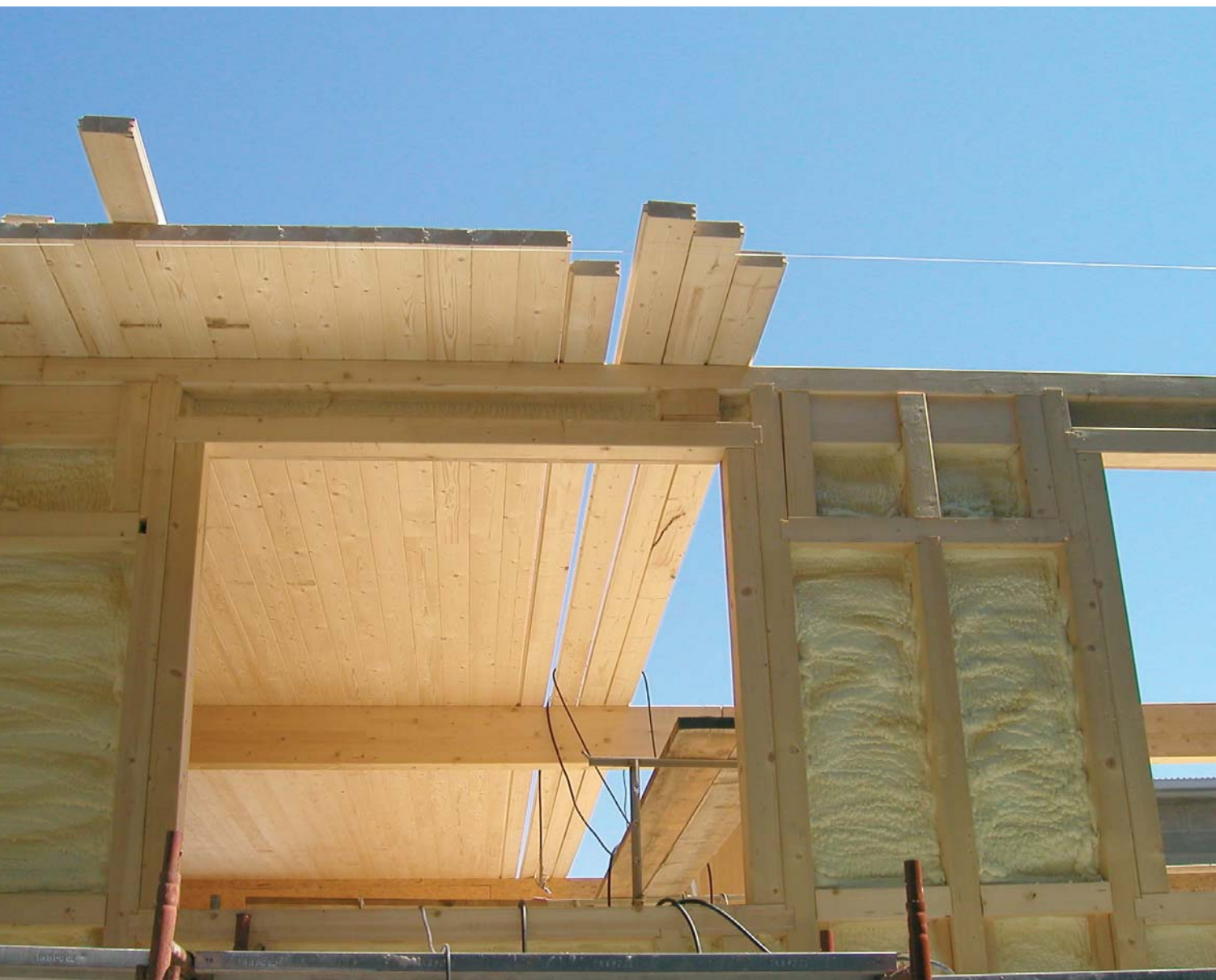
Una fase della posa delle aste in KVH a doppia maschiatura.
