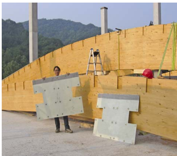
Figura 30: Esempio di Giunto Italia® a doppio inserto in GFRP
