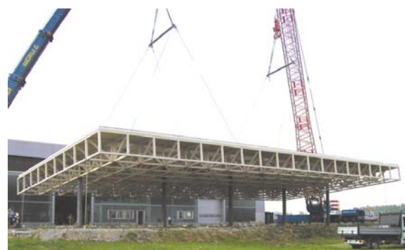
Figura 8: Sollevamento di una pensilina reticolare spaziale di 1.000 m 2 a Bregnano, costruita a terra in un sol pezzo, con aste collegate con giunti CNP (2002)
