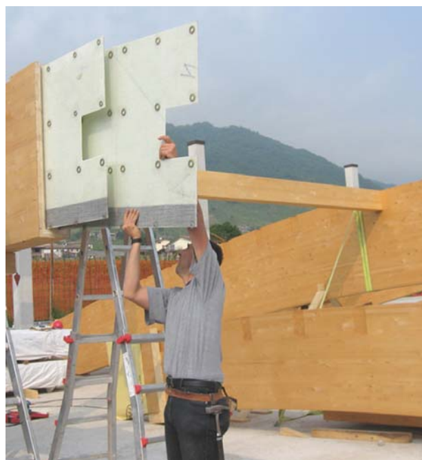
Figura 32: Applicazione di un Giunto Italia® a doppio inserto in GFRP con nastri di rinforzo in carbonio
