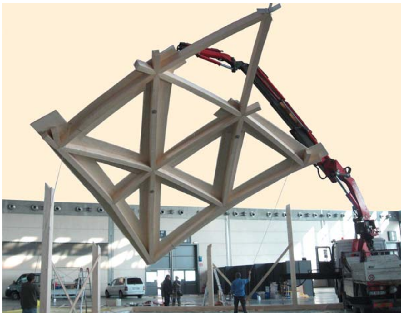
Figura 33: Rassegna TechnoDomus, RiminiFiera, marzo 2009. Ipotesi di una membrana spaziale in legno lamellare e stuoie PolyeveryG800; per i collegamenti multidirezionali è stato progettato un Giunto Italia® plurivie in GFRP
