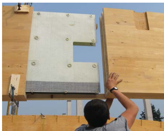
Fig. 3 - GIUNTO ITALIA in laminati CGFRP confezionati in "in situ" (De Prà)
